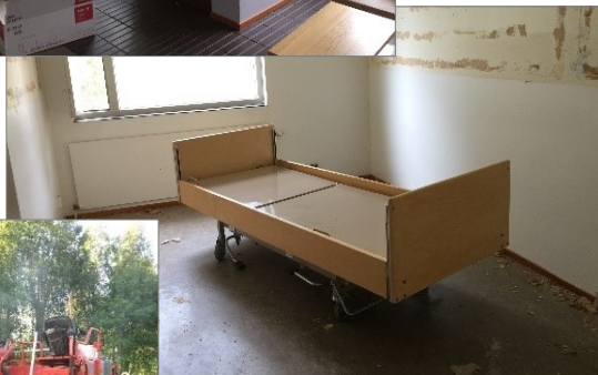
1 soluasunnon purkutyöt käynnissä.
