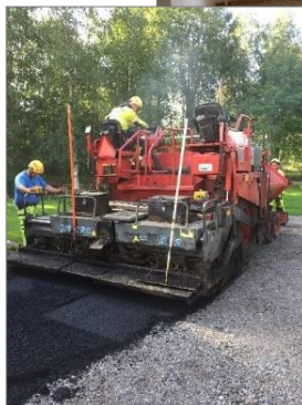
Jo remontoitujen 2-4 soluasuntojen pihat asfaltoitiin helpottamaan liik- kumista.
