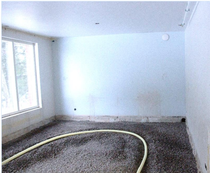
Kuva 2. Opiskelija-asuntoloiden remontti käynnissä – lattiat uusitaan ja asennetaan lattialämmitys.
