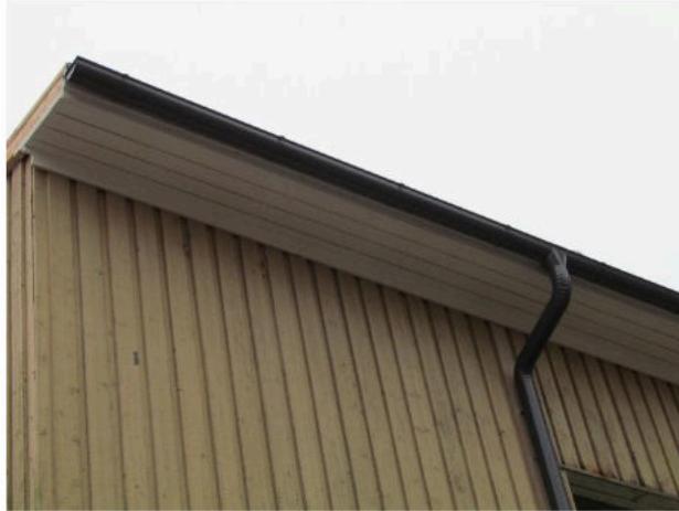
Kuva 1 Juhlasalin katto kestää taas sateita vuosiksi eteenpäin
