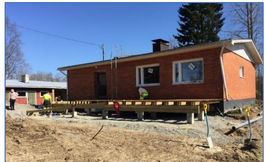
Yllä rakennusmiehet piharakennuksen purkuhommissa ja uuden kuistin rakennuspuuhissa.
